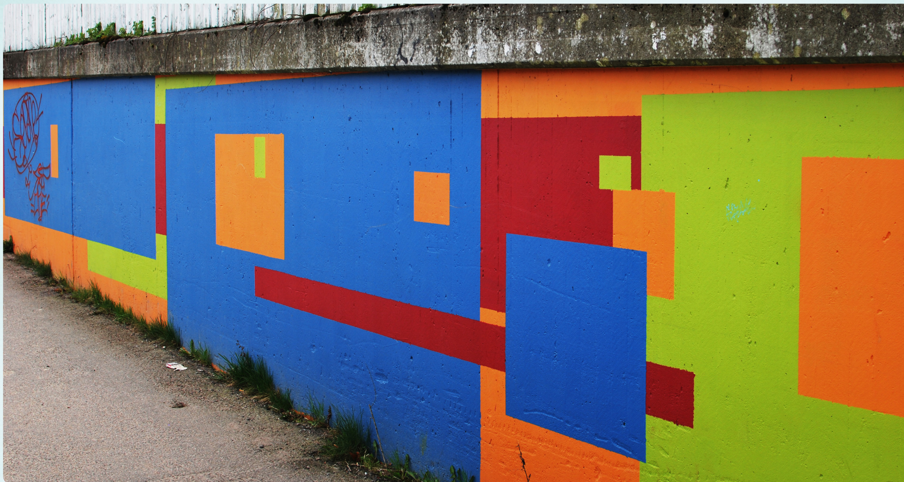
Figur 11: Klottersanering med färg.
